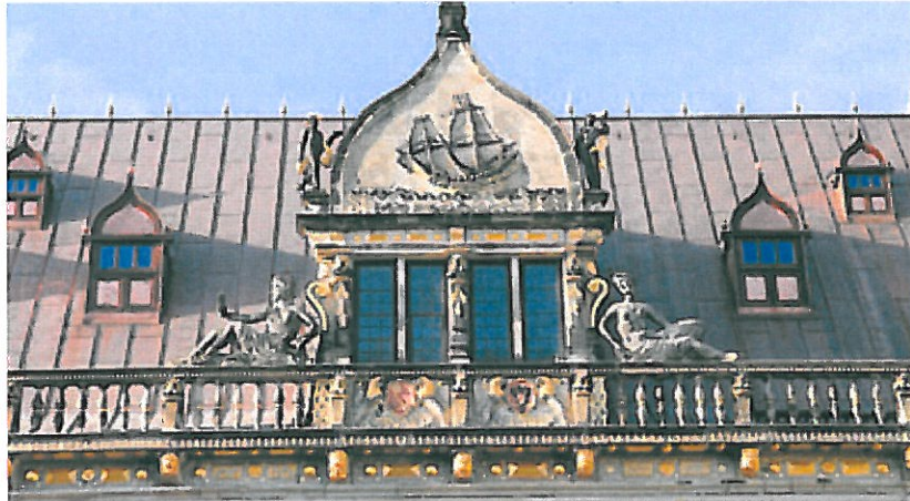
Mit der Kupfereindeckung und den Gauben ist die Original-Optik wiederhergestellt.
